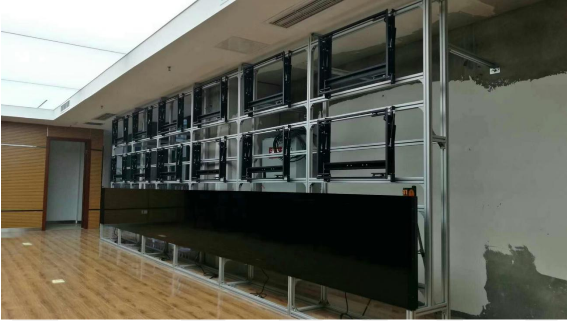
3. 落地机柜/落地前维护机柜
