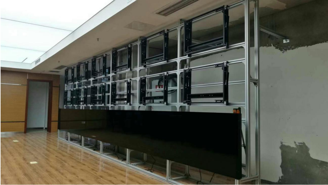
3. 落地机柜/落地前维护机柜
