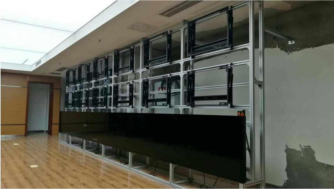
3. 落地机柜/落地前维护机柜
